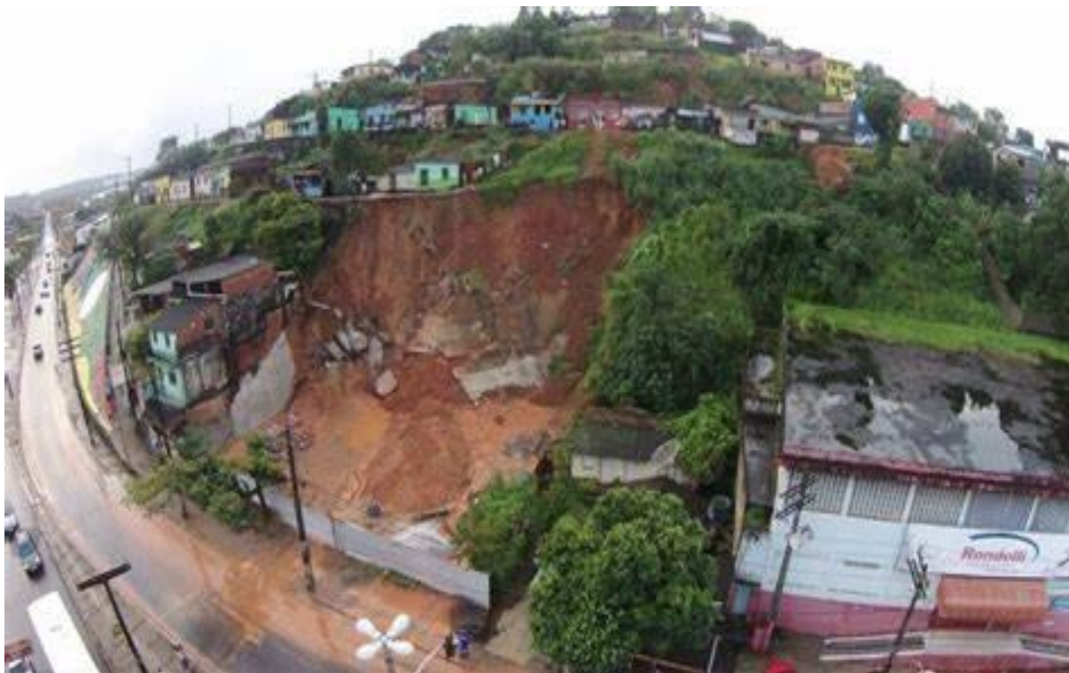
Figura 8 - Deslizamento de terra no alto da Legião, bairro Malhado, Ilhéus
