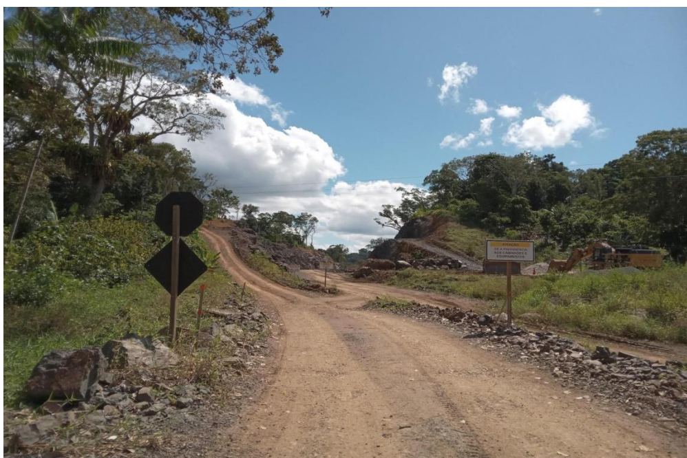
Figura 5 - Trecho de construção da ferrovia Leste-Oeste em Ilhéus-BA
