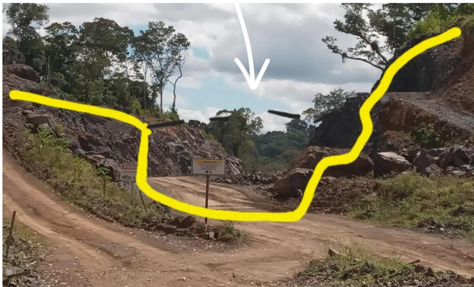
Figura 6 - Área rebaixada por meio da retirada de blocos rochosos
