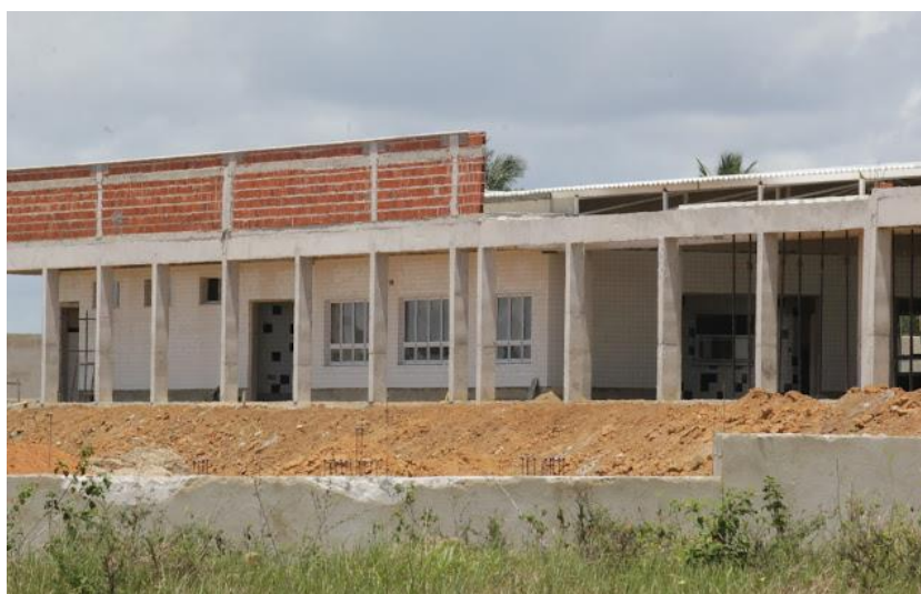
Figura 10: Construção do Colégio Modelo Luis Eduardo Magalhães no distrito de São João do Paraíso, Município de Mascote-BA
