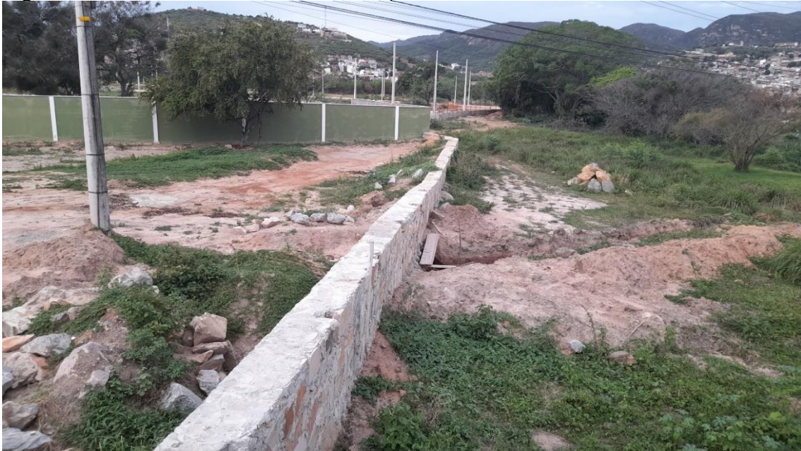
Figura 5 – Medida estrutural realizada por condomínio
