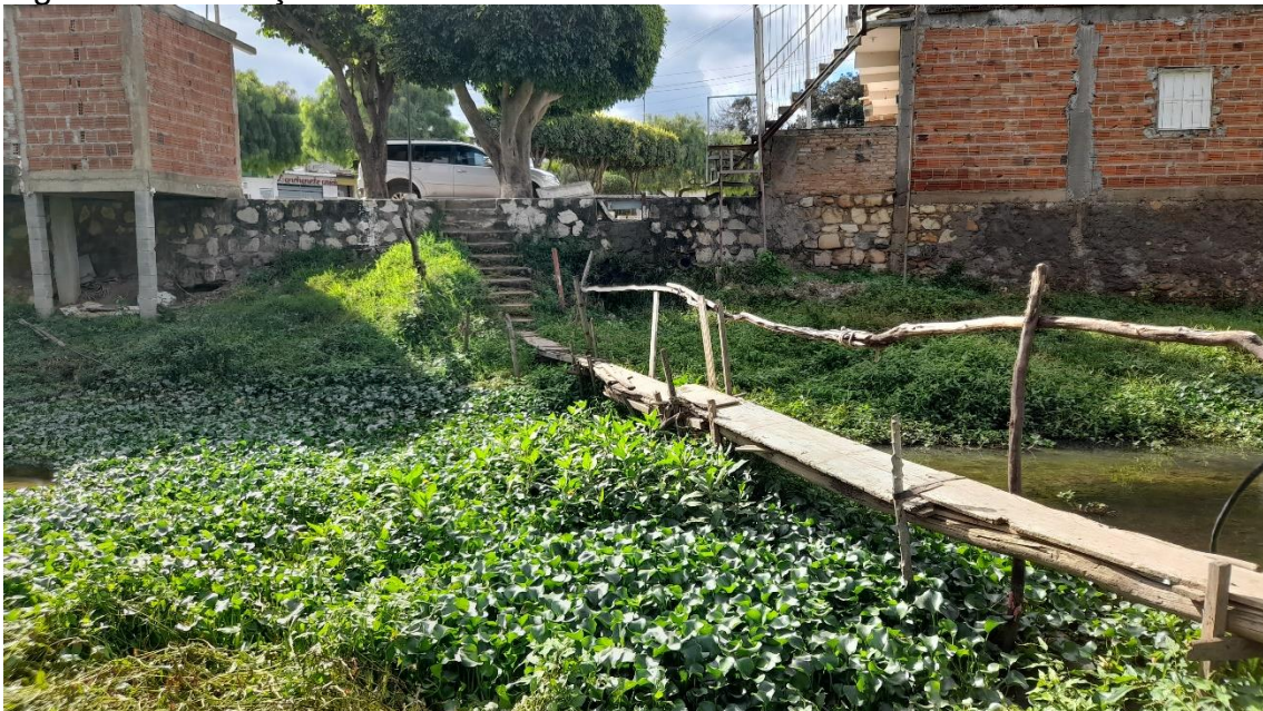
Figura 6 – Utilização de medida estrutural como alicerce no bairro Nazaré
