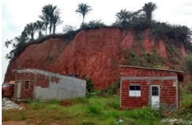
Figura 4 - Área de risco Rua. Barro vermelho Teotônio Vilela
