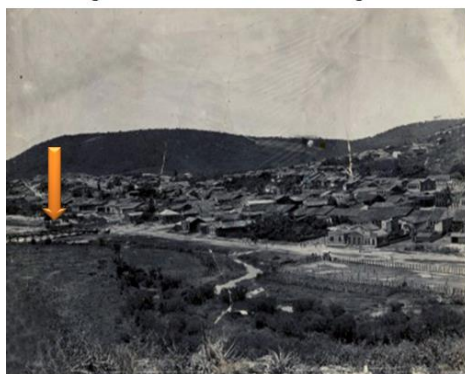
Figura 4a - Rio Itapicuru Mirim, 1940 - Antiga Ponte de madeira da ‘Pinguela’.
