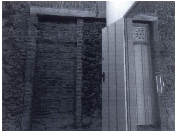
Figura 8: Fotografia identificando a parede de alvenaria de pedra junto com alvenaria de tijolo na restauração da edificação para constituir-se em sede do escritório do IPHAN-RN, nas reformas e restaurações de 1995. FONTE: Análise Técnica da FJA – junho/2015. Com base nos relatórios de tombamento e restauração do IPHAN-RN.
