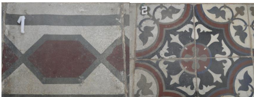
Figuras 1 e 2 – Padrões decorativos dos tipos 01 e 02 nos pisos atuais da Casa. No primeiro tipo, à esquerda, os motivos decorativos são com polígonos de seis lados na cor vinho e delimitados por faixas na cor cinza com fundo branco, e demarcado por faixas também na cor cinza. No segundo tipo, à direita são motivos florais demarcados por faixas na cor vinho e cinza formando mosaicos.
