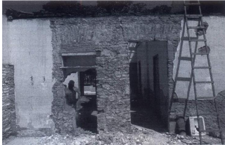
Figura 7: Fotografia do momento da retirada do reboco e identificação da parede de alvenaria de pedra-e-cal, na parte posterior do imóvel nas reformas em 1995. FONTE: Análise Técnica da FJA – junho/2015. Com base nos relatórios de tombamento e restauração do IPHAN-RN.
