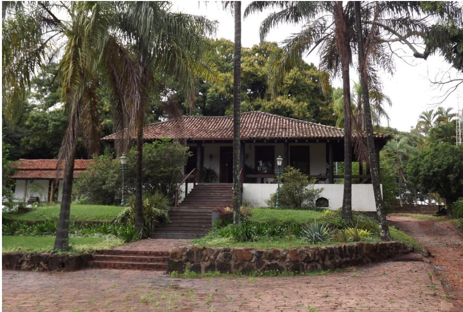
Figura 3. Fachada casa sede da Fazenda Santo Antônio da Água Limpa
