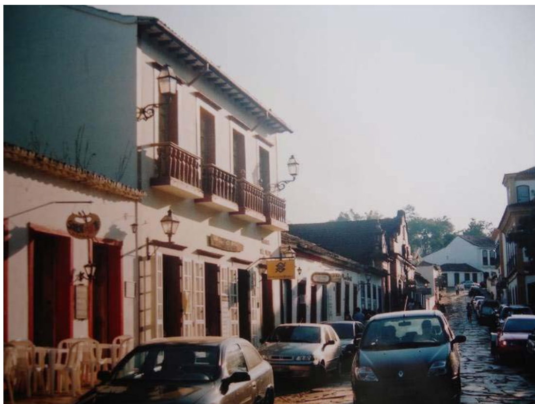
Fig. 5 – Tiradentes: Boas técnicas de restauro, porém, população distante do processo Foto do autor: 2008
