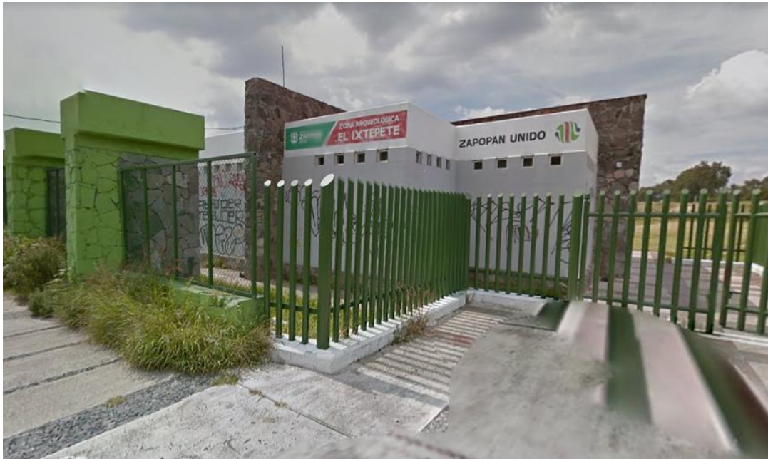
Figura 3. Muro perimetral del sitio arqueológico El Ixtepete, en el que se puede apreciar el vandalismo
