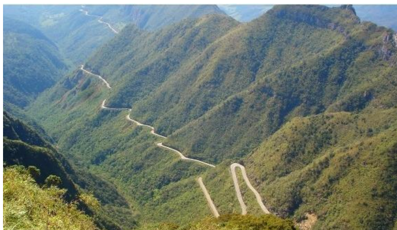
Figura 2 - Rodovia SC-438 - Serra do Rio do Rastro Fonte: Prefeitura Municipal de Lauro Muller, SC.
